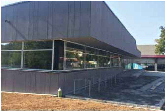
Baustelle am neuen Schwimmbad.
