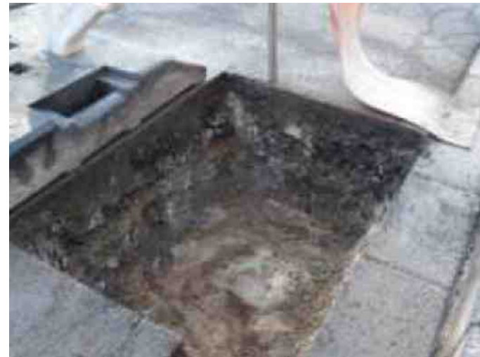
Bogenbereich: kein Schutzbeton, nur loses Material
